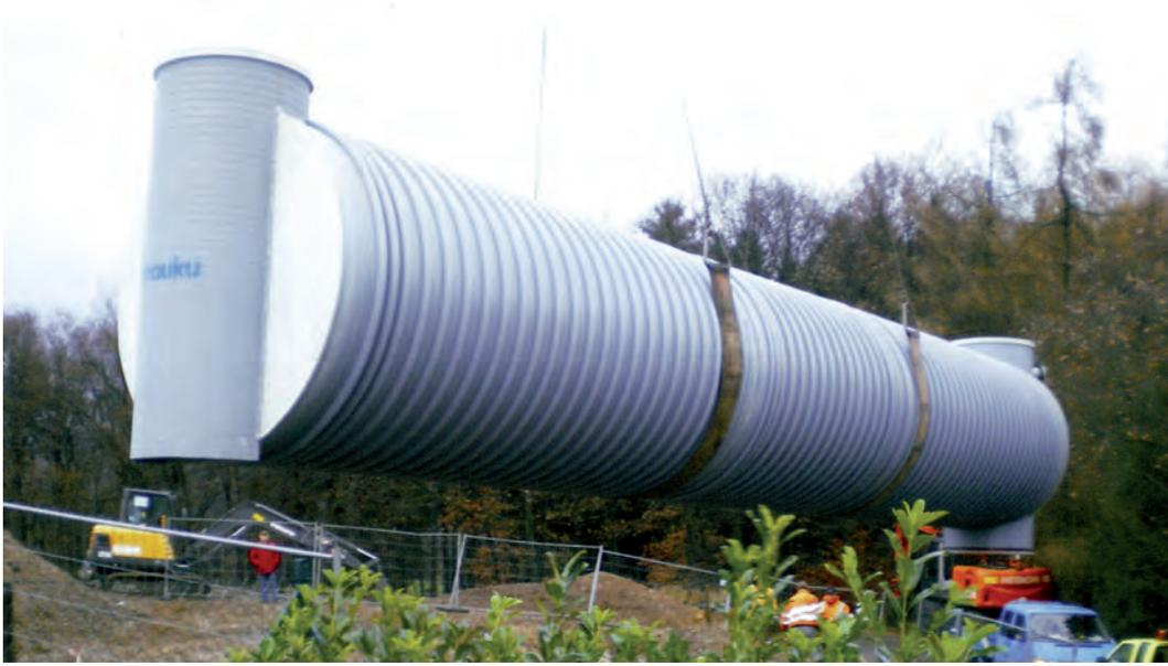
Eine hohe Ringsteifigkeit bei gleichzeitig geringem Bauteilgewicht ermöglicht die Anlieferung von komplett vorgefertigten Speichertanks bis ca. 160m<sup>3</sup>.
