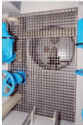
La chambre de drainage est recouverte d'un grillage en plastique armé à la fibre de verre. Il est ainsi plus facile de retirer les éléments du grillage pour le nettoyage.
